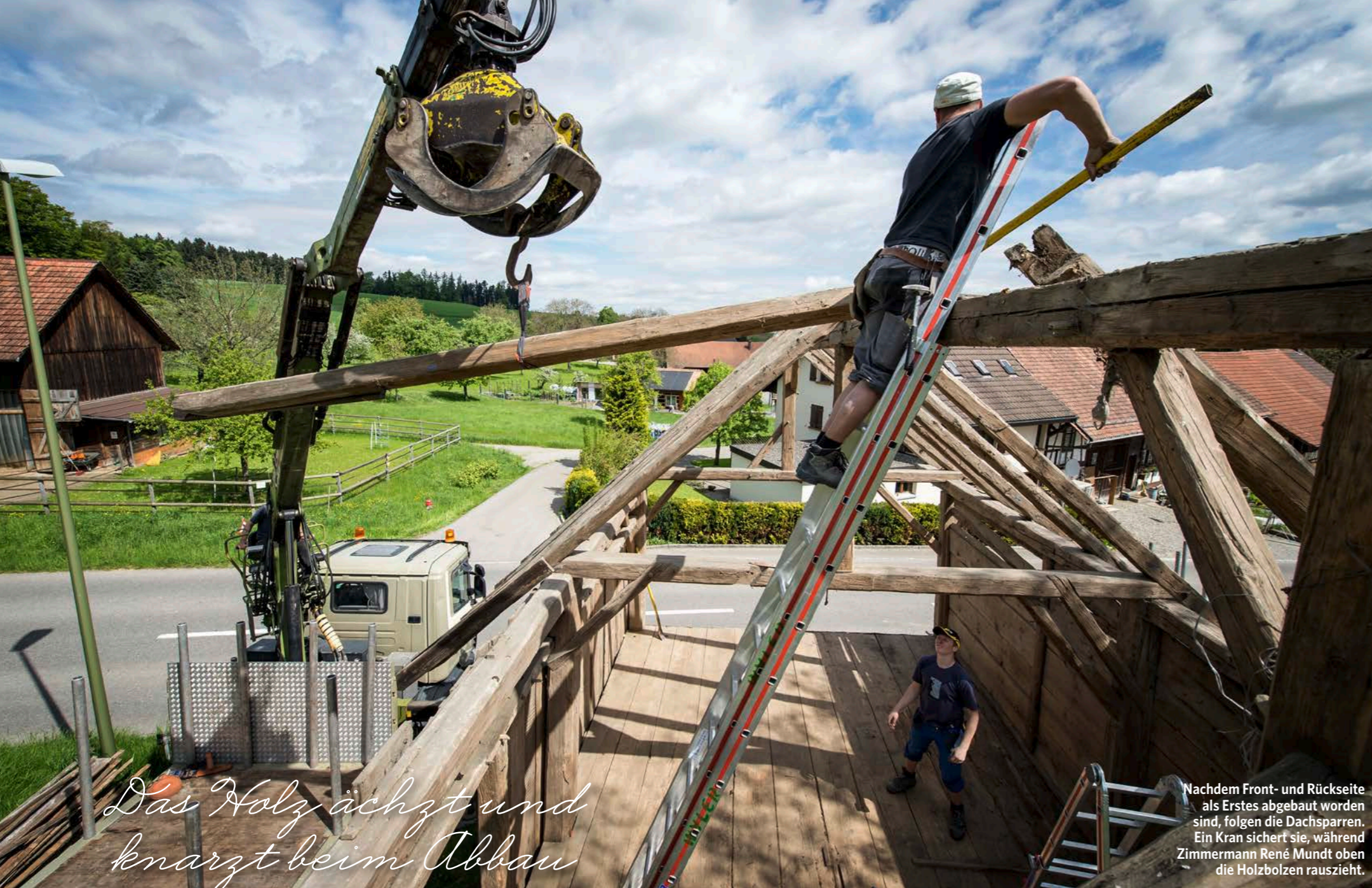
Jedes Brett erhält vor der Demontage eine Nummer, die in den Plänen vermerkt wird. Die Buchstaben stehen für die Himmelsrichtungen, die Zahlen für die Reihenfolge von links nach rechts.
